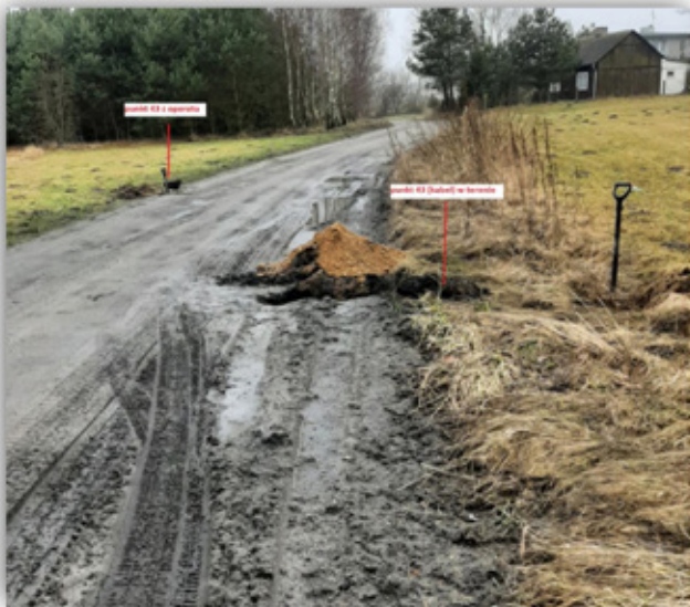
Zdjęcie: po lewej stronie drogi kabel wg operatu, a po prawej faktycznie w terenie.
